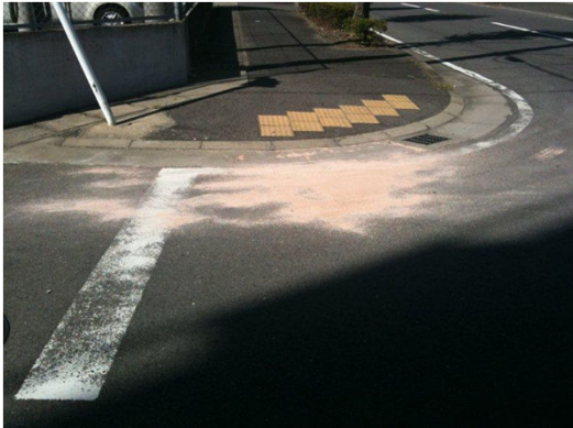
交通事故によるオイル処理 (回収しないでそのまま放置)
